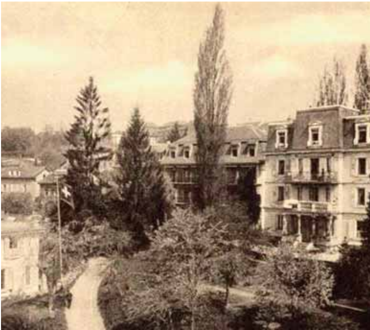
L'École-hôpital de La Source, hier
